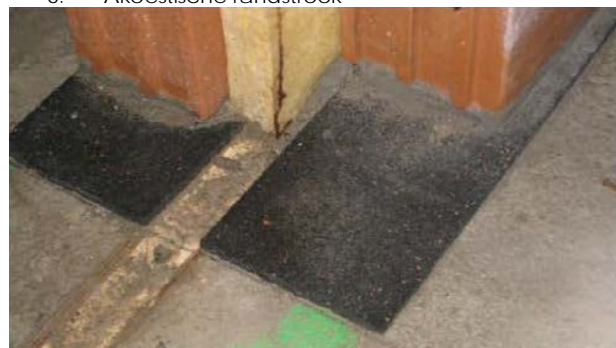
Foto 1: Voorbeeld van een muurstrook onder het metselwerk.
