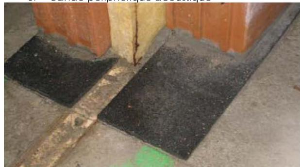
Photo 1 : Exemple de bande murale appliquée sous la maçonnerie.
